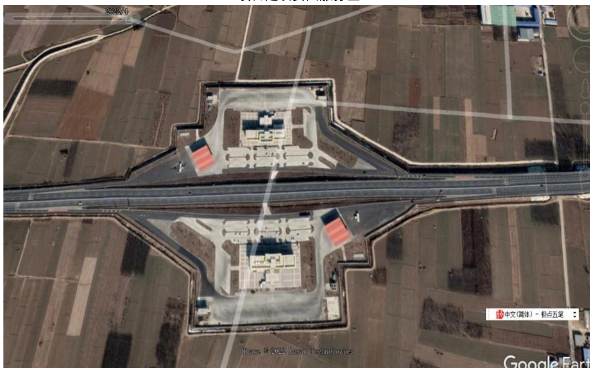
项目建成后安国服务区 (2022 年)
