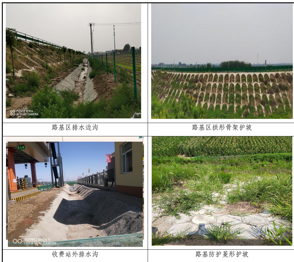
图 3-7 实际实施工程措施现状照片
