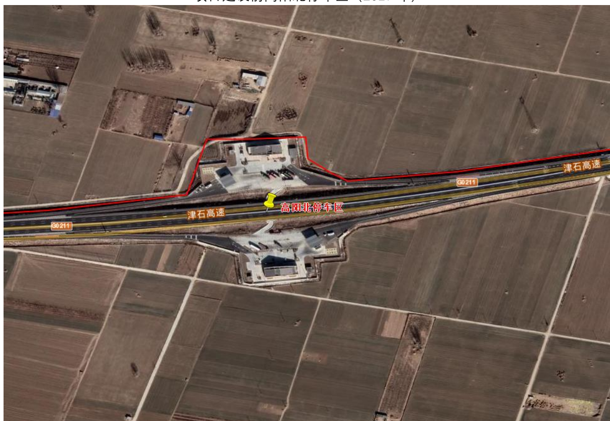
项目建成后高阳北停车区（2022年）
