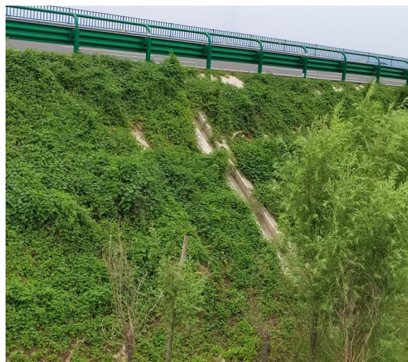
边坡植草、排水沟
